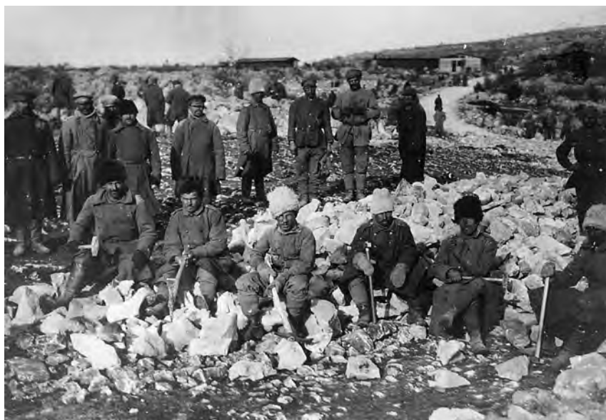
FOTO 27: GRADNJA VODOVODA NA KRASU. VIR: KOBARIŠKI MUZEJ.
