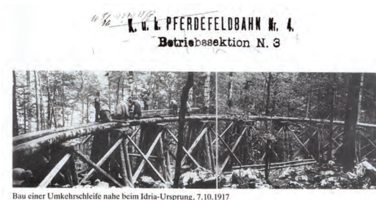
Bau einer Umkehrschleife nahe beim Idria-Ursprung, 7.10.1917
